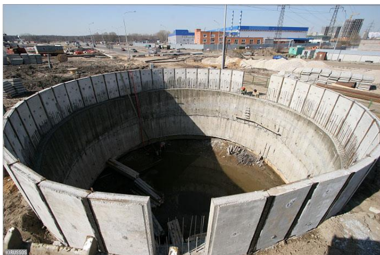
Рис. 4.7. Общий вид фундамента в виде опускаемого колодца
