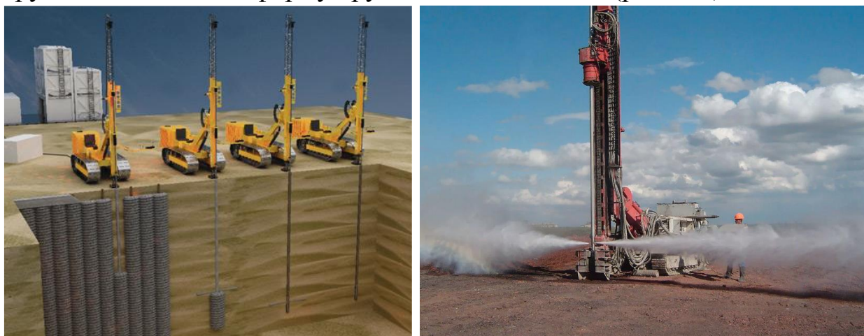
Рис. 4.4. Технология струйной цементации (Jet Grouting)
